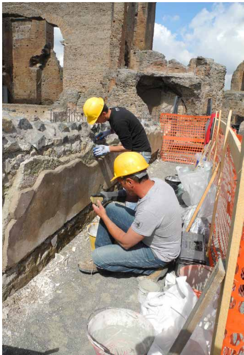
Interventi di restauro e manutenzione alla Villa dei Quintili
