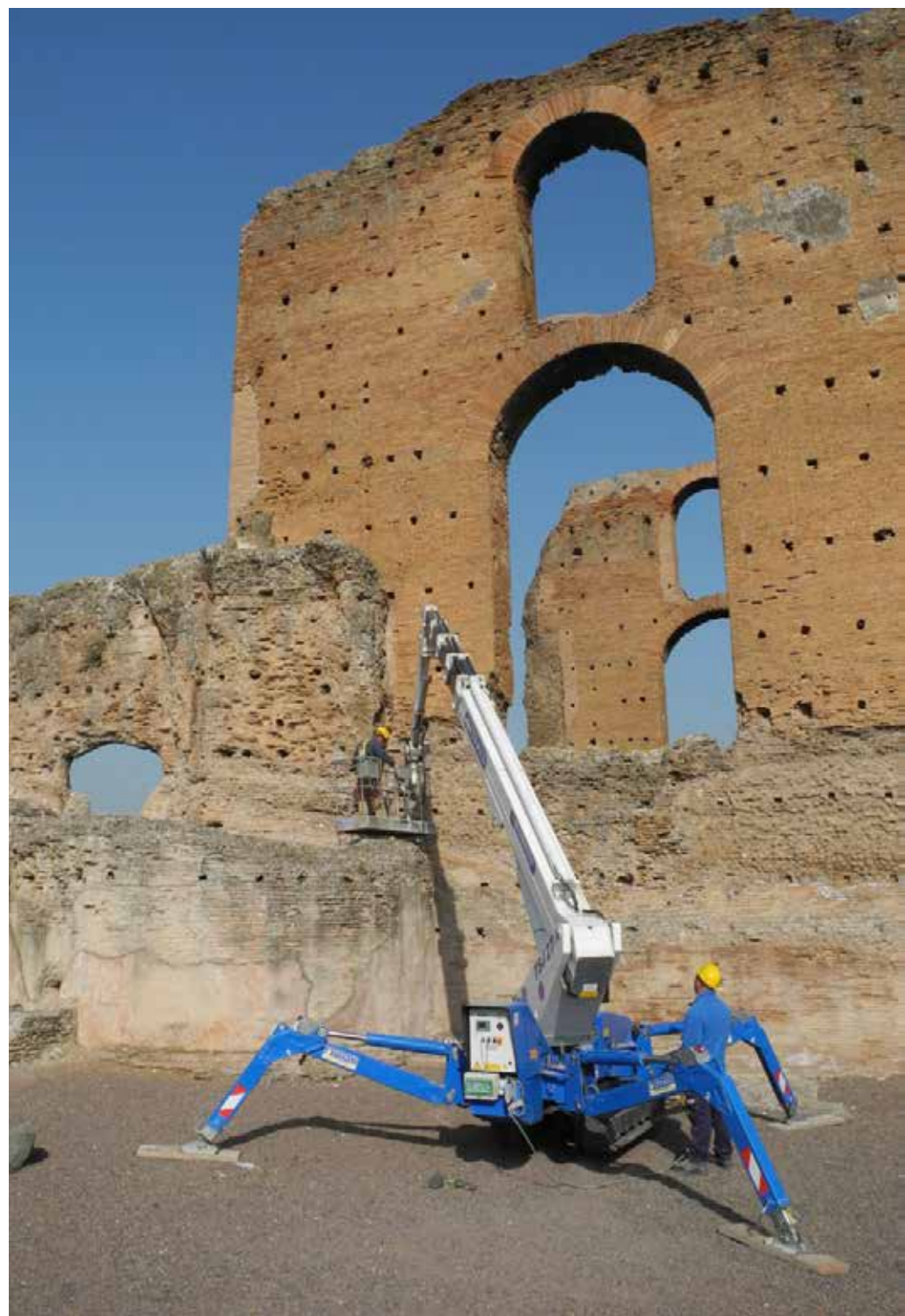
Interventi di restauro e manutenzione alla Villa dei Quintili
